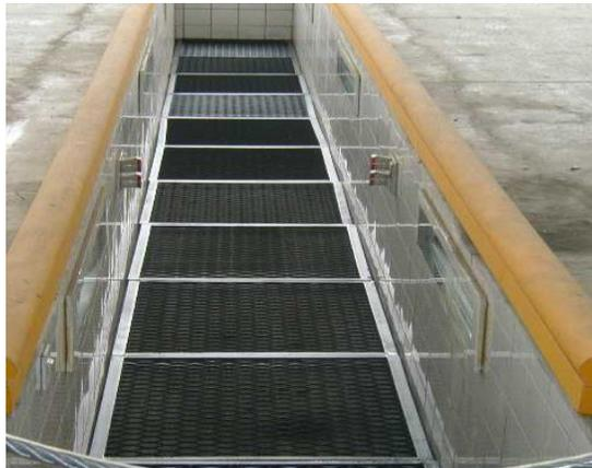
Debe permitir un perfecto escurrimiento de líquidos de manera natural o mecánica. El acceso a los fosos debe ser efectuado por escaleras fijas o rampas cuando se trata de fosos inter conectados.
